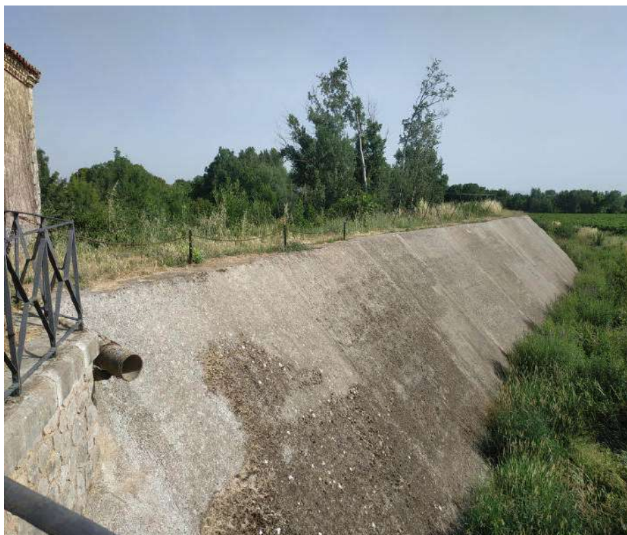
FIGURE 41 : PHOTOGRAPHIE DE LA DIGUE ENTOURANT LE VILLAGE – SOURCE : EGIS
